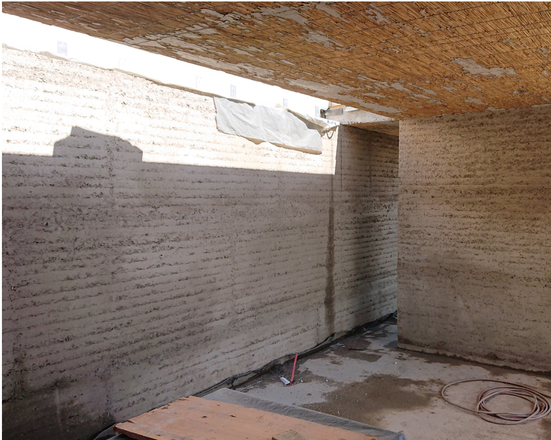
Atelier aha im Bau, Stampflehmwände Bild: Patrick Krecel
