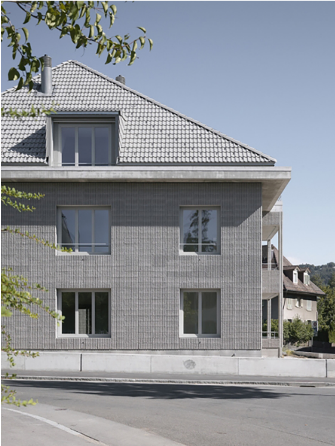
Wohnhaus Zwyszigstrasse 12/14, Bern - Mattenhof, Atelier Scheidegger Keller Bild: Karin Gauch und Fabien Schwartz
