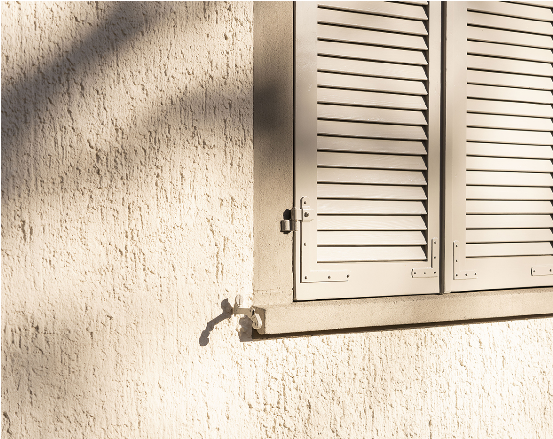
Der neue Verputz wurde nach der originalen Bausubstanz rekonstruiert Bild: Karl Bubenhofer AG
