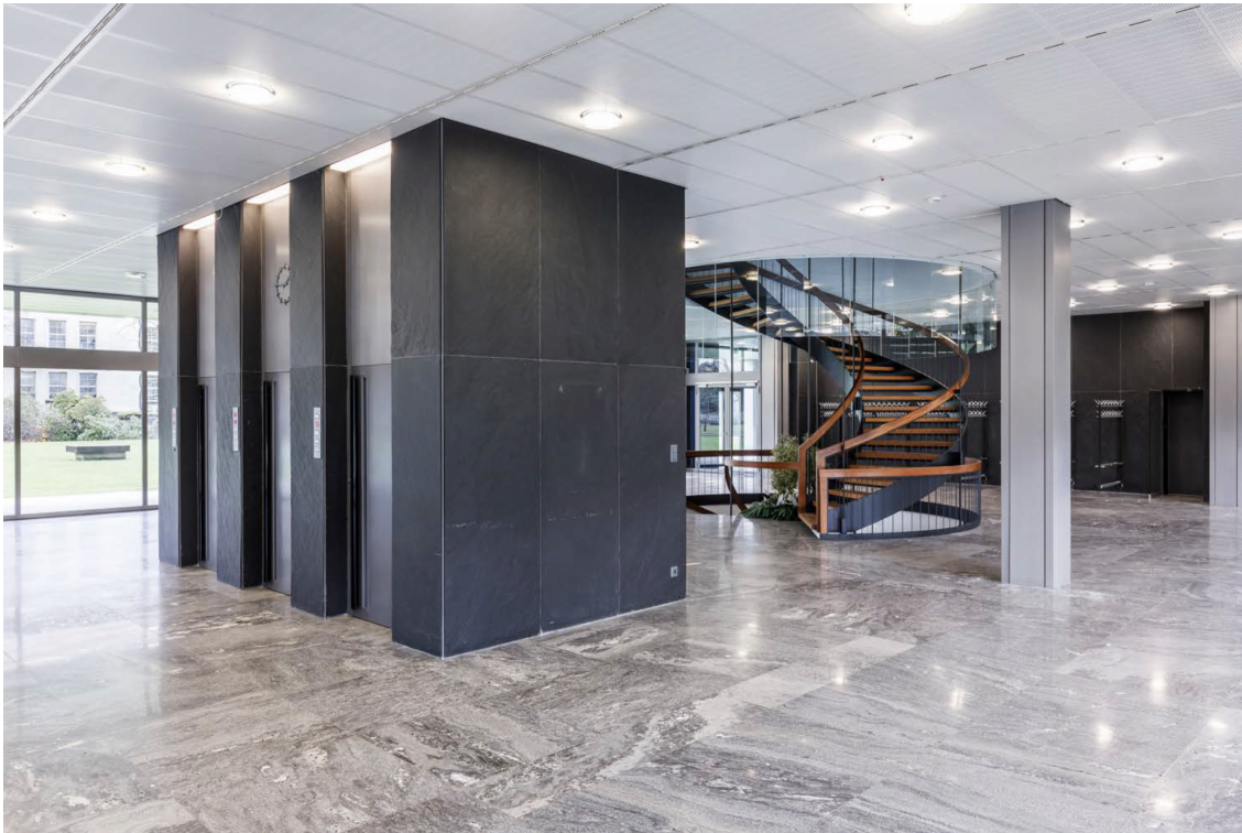
Der Granitboden, die Wandplatten aus Schiefer und die Wendeltreppe wurden aufgefrischt und weiterverwendet Bild: MOKA Architekten
