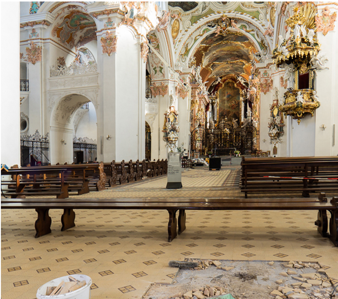
Restaurierung der Stiftskirche Einsiedeln mit Reproduktionen der Originalfliesen Bild: Zahna-Fliesen
