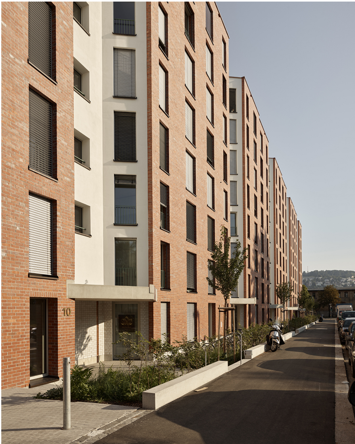
Wohnsiedlung Hohl-, Freihofstrasse, Adrian Streich Architekten Bild: Roland Bernath
