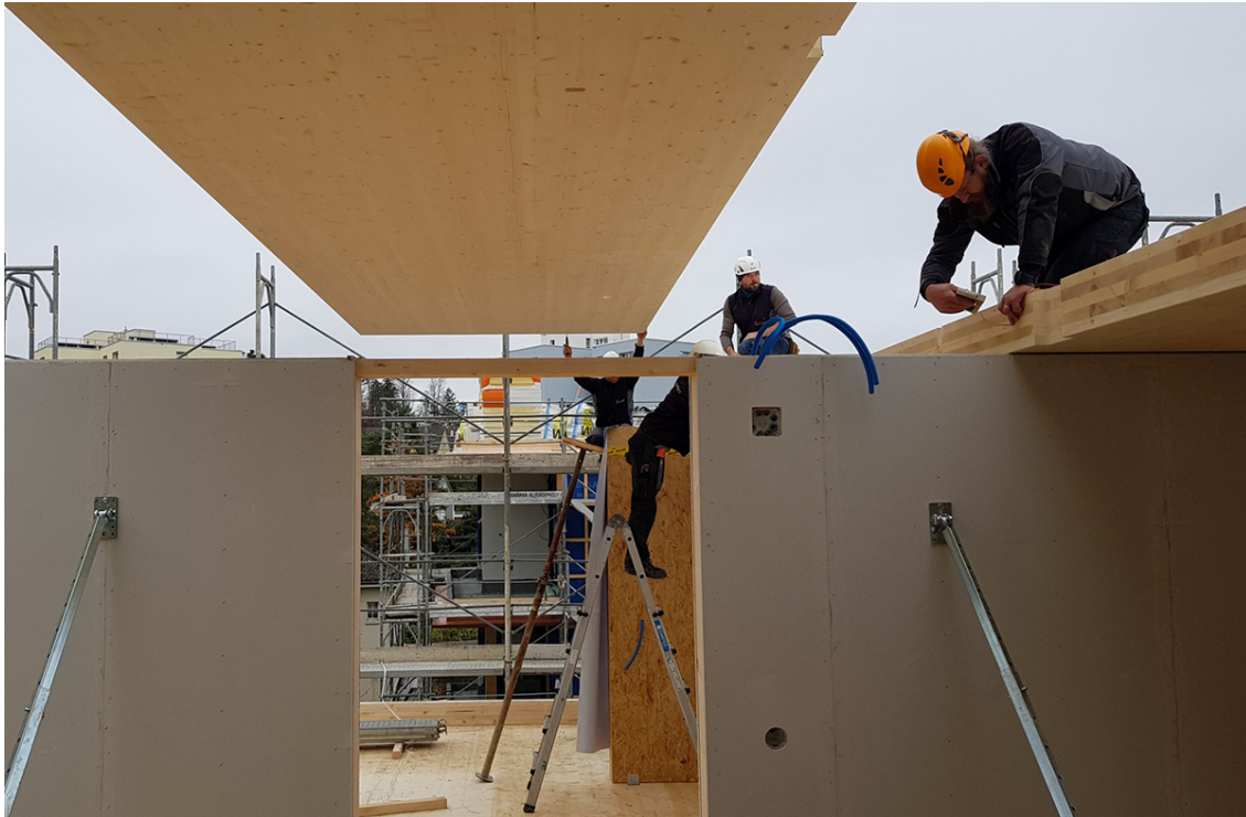
Die Holzplatten werden auf der Baustelle zusammengeklebt, Baustelle Zollikerberg Bild :merkli degen architekten eth
