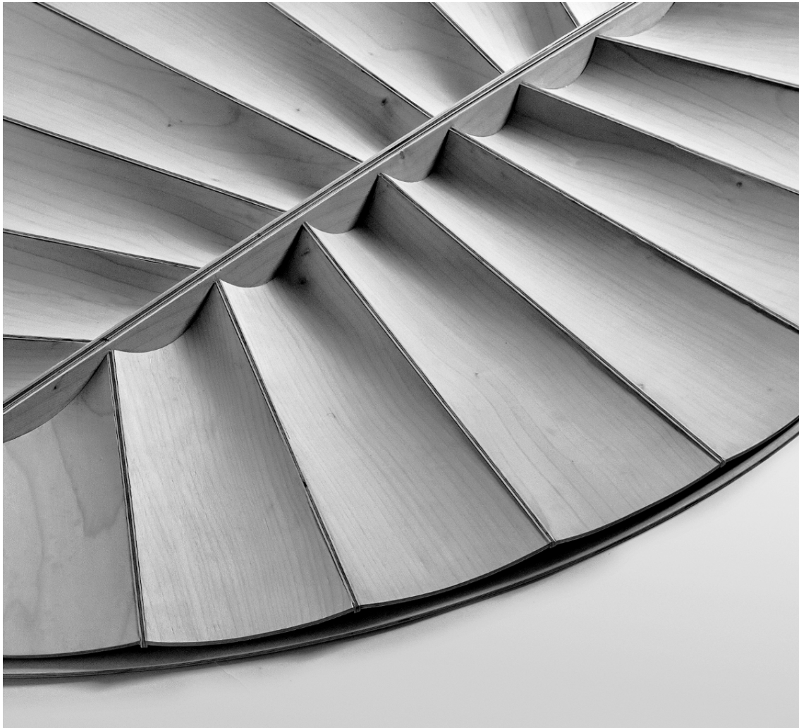
Tragwerk aus Formsperrholz, Bild: Lukas Ingold
