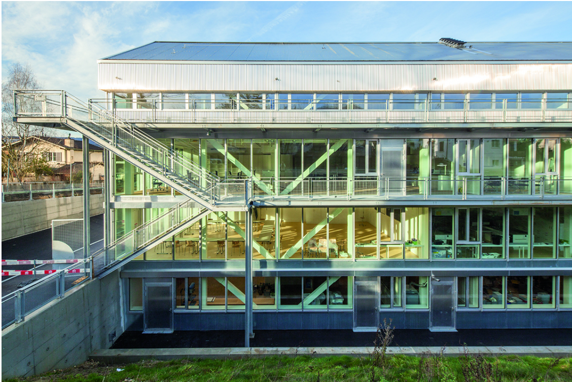
Sekundarschule Laufen, Basel; 2014-2021, Thomas Fischer Architekt Bild: Michael Buehler
