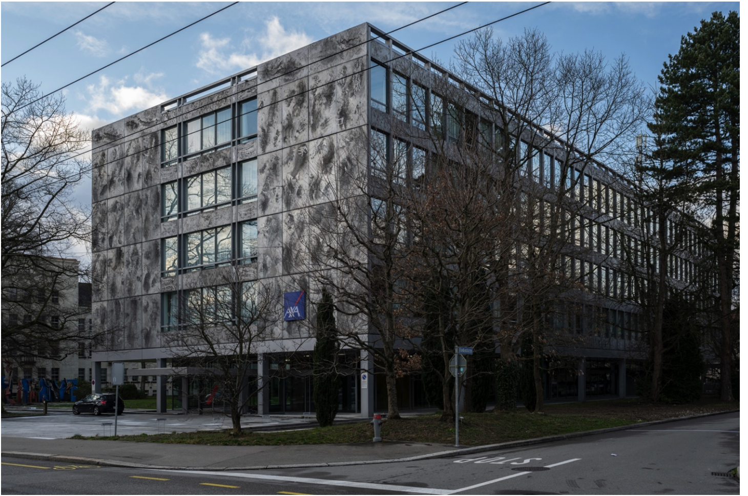
Das umgebaute Axa-Gebäude in Winterthur nutzt viele der vorhandenen Bauteile neu ...
