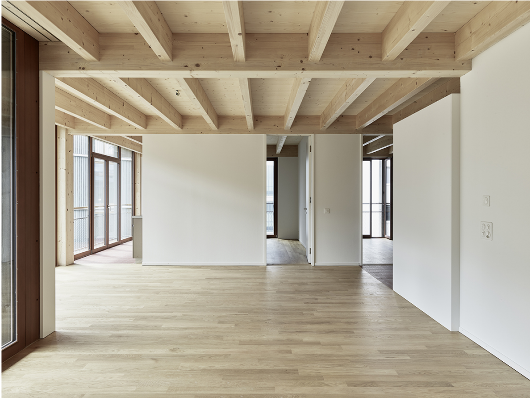
Die sichtbare Balkendecke prägt die Innenräume der Wohnüberbauung Maiengasse, Foto: Kuster Frey
