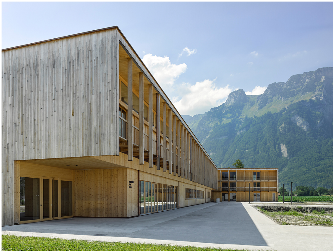
Das Landwirtschaftliche Zentrum ist oberhalb der Bodenplatte konsequent aus Holz erbaut. Foto: Seraina Wirz
