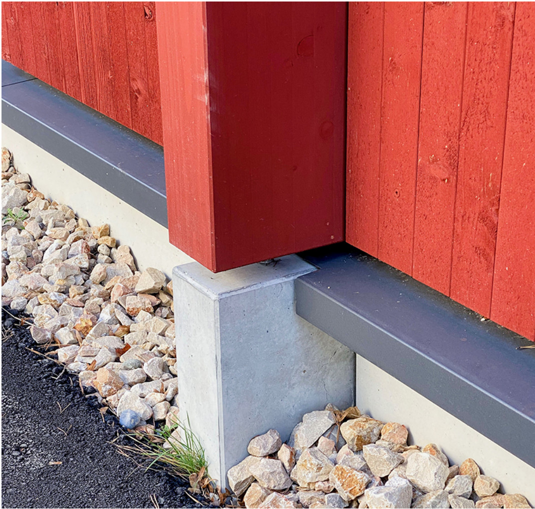
Anschlussdetail der gestrichenen Holzfassade zum Boden
