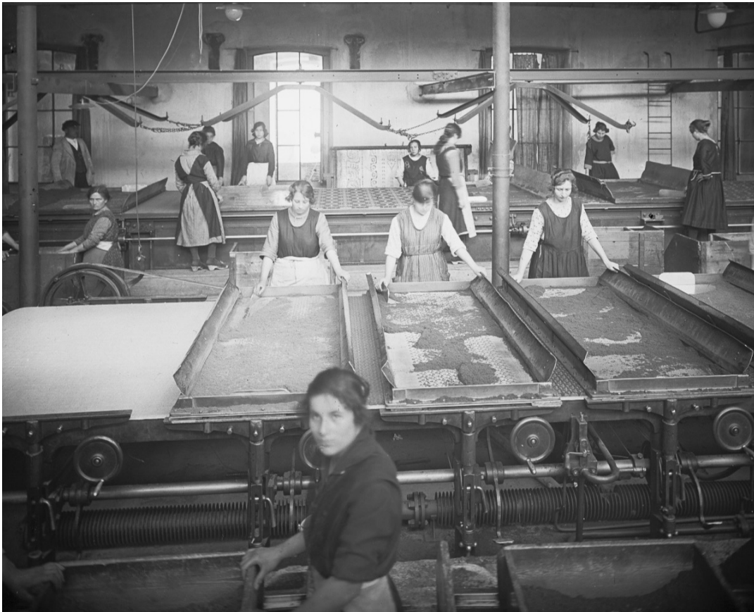
Herstellung eines Inlaidlinoleum, Linoleum AG Giubiasco, Anfang des 20. Jahrhunderts
