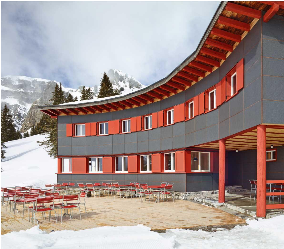
Das Ortstockhaus nach der Sanierung im Jahre 2017 Foto: Hannes Henz
