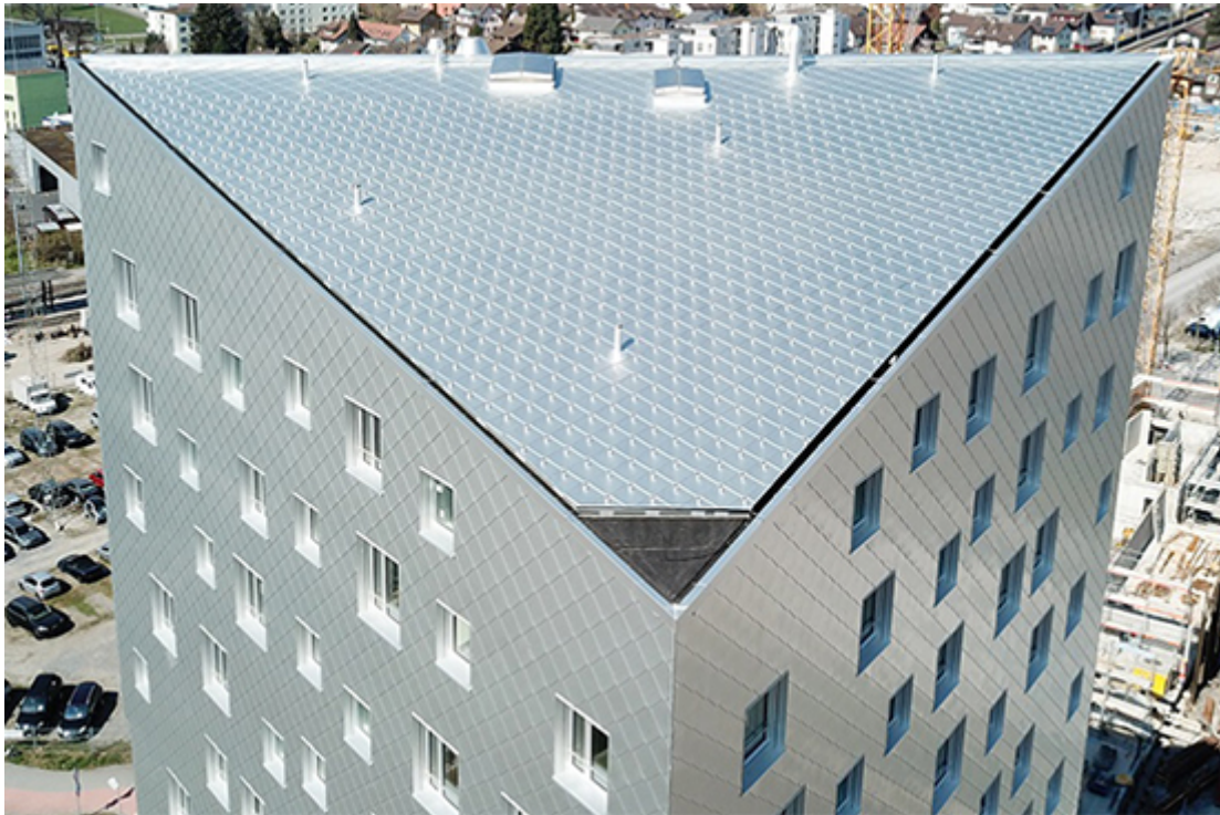
Fassade und Dach sind mit den Aluminiumrauten verkleidet Bild: PREFA
