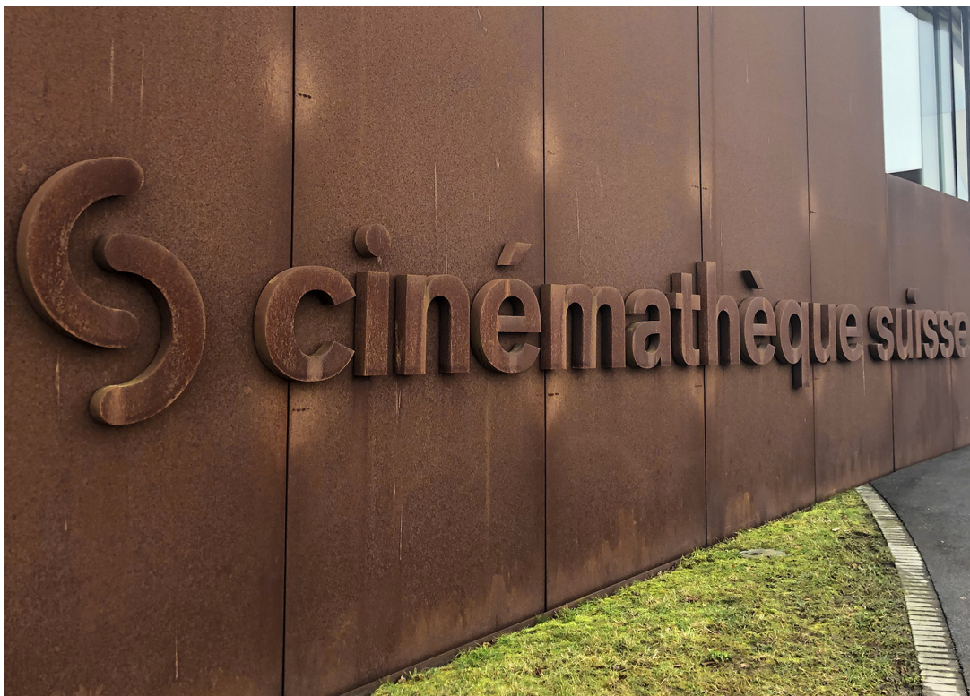
Die Fassade aus unbehandeltem Baustahl der Cinémathèque Suisse in Penthaaz. Architektur, EM2N
