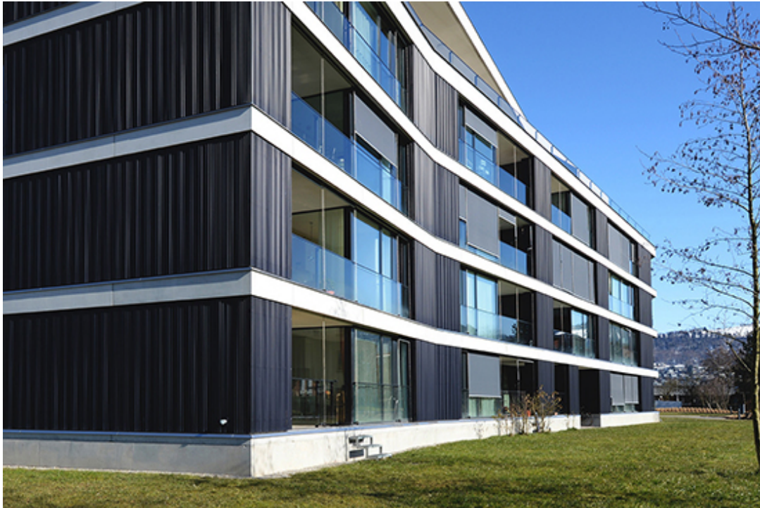
Fassade aus Montana Profilplatten, Siedlung Riedpark Zug, em2n Architekten + Müller Sigrist Architekten
