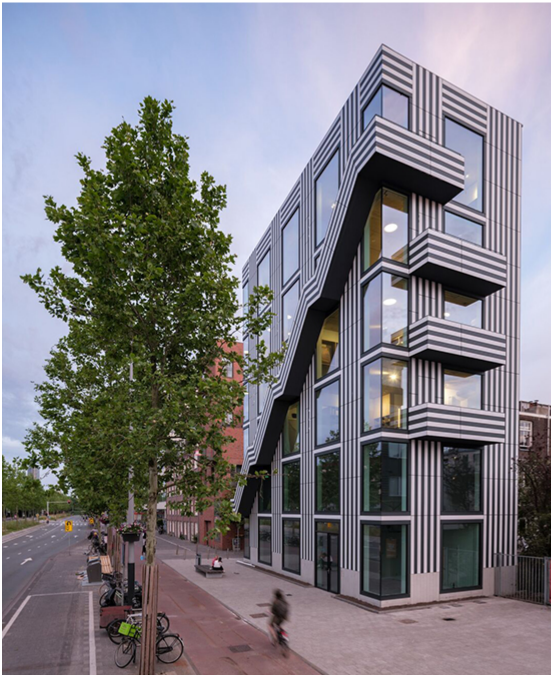
Hinterlüftete Fassade mit Trespa Meteon, Studio Thonik, Amsterdam, MXX Architects, 2020 Bild: Ossip van Duivenbode
