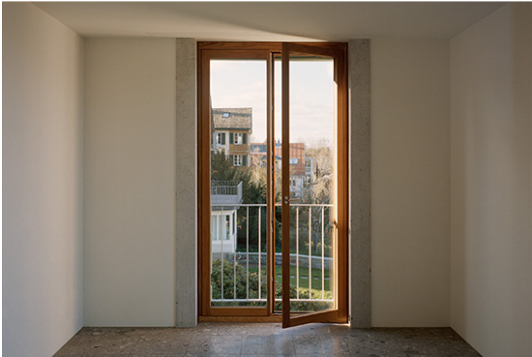
Fenster, angeschlagen an Betonpfeiler, Mathis Kamplade Architekten 2015–2019 Bild: Rory Gardiner
