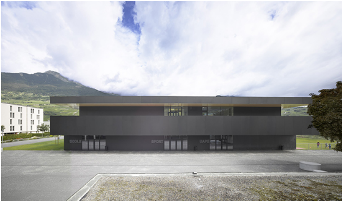
ECC - Ecole Chateauneuf, Bonnard Wœffray Architectes 2015, Bild: Hannes Henz
