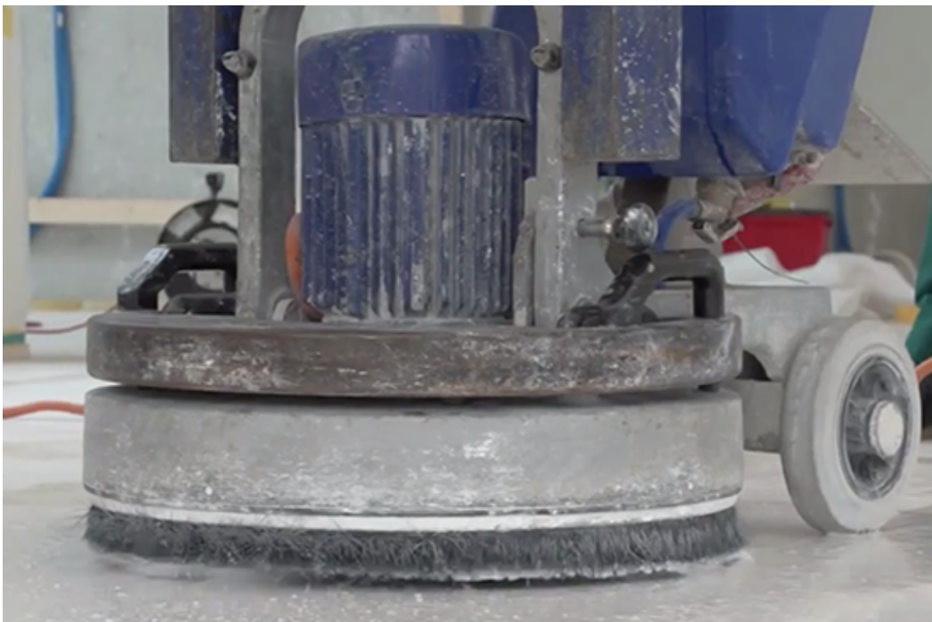
Grundreinigung des Bodenbelags als erster Schritt
