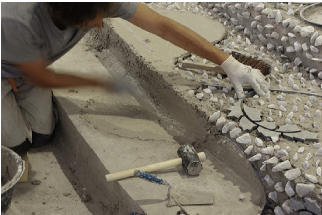
Einlagern der Natursteinsplitter
