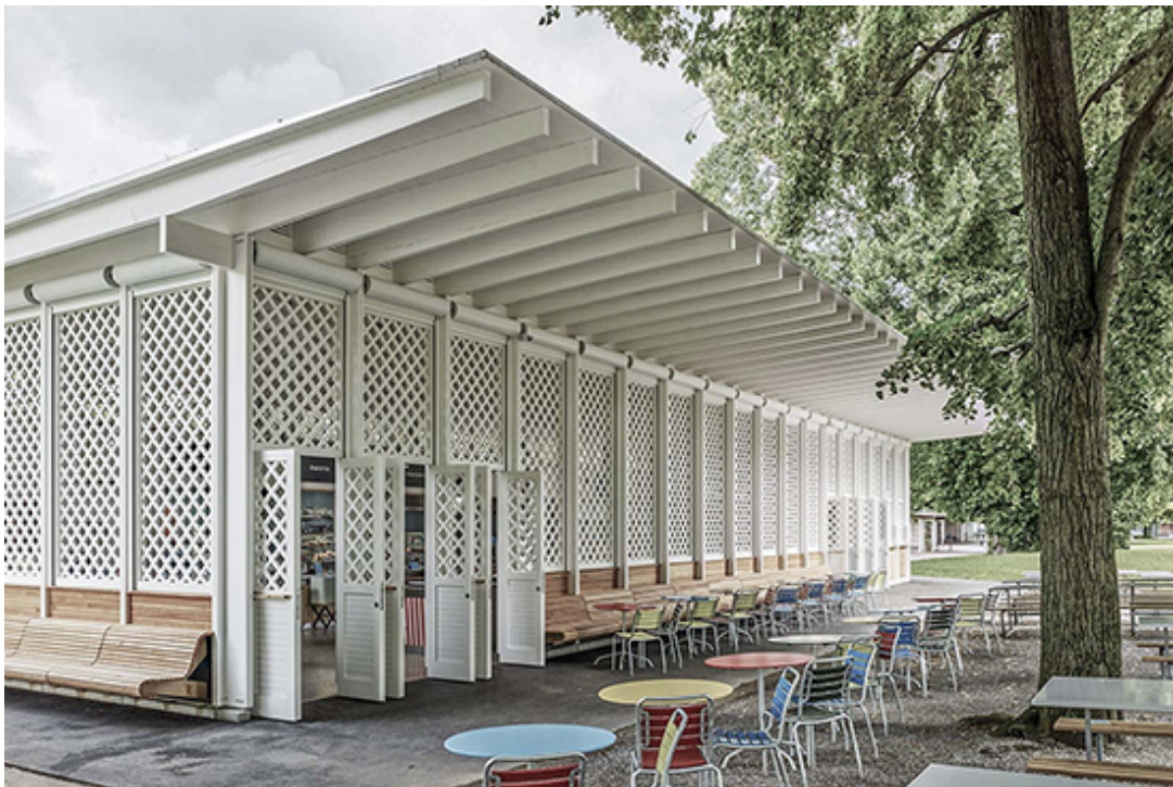
Strandbad Mythenquai Zürich, ARGE Elia Malevez & Spiro und Gantenbein, 2013, Bild: Küng Holzbau AG
