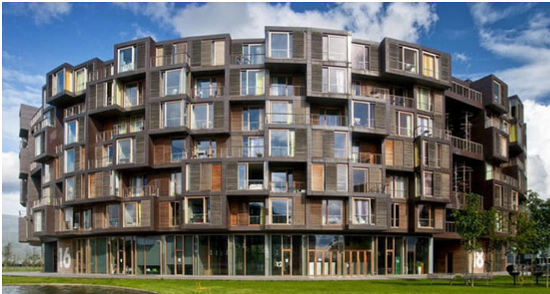
Studentenwohnheim «Tietgenkollegiet» im Kopenhagener Stadtteil Ørestad. Lundgaard & Tranberg Architekten, 2006
