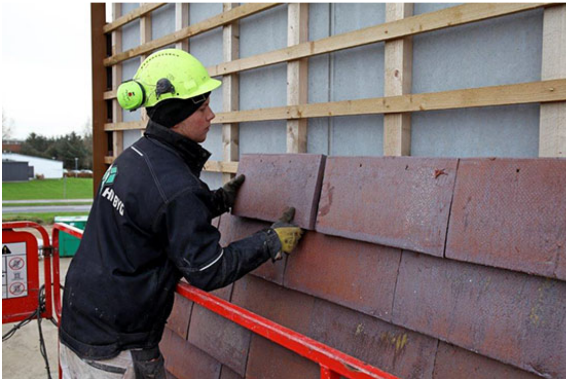
Montage von Petersen Cover in der Fassade
