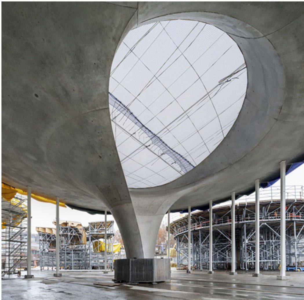
Fertiggestellte Kelchstütze für den neuen Durchgangsbahnhof «Stuttgart 21», Ingenieurbüro Werner Sobek
