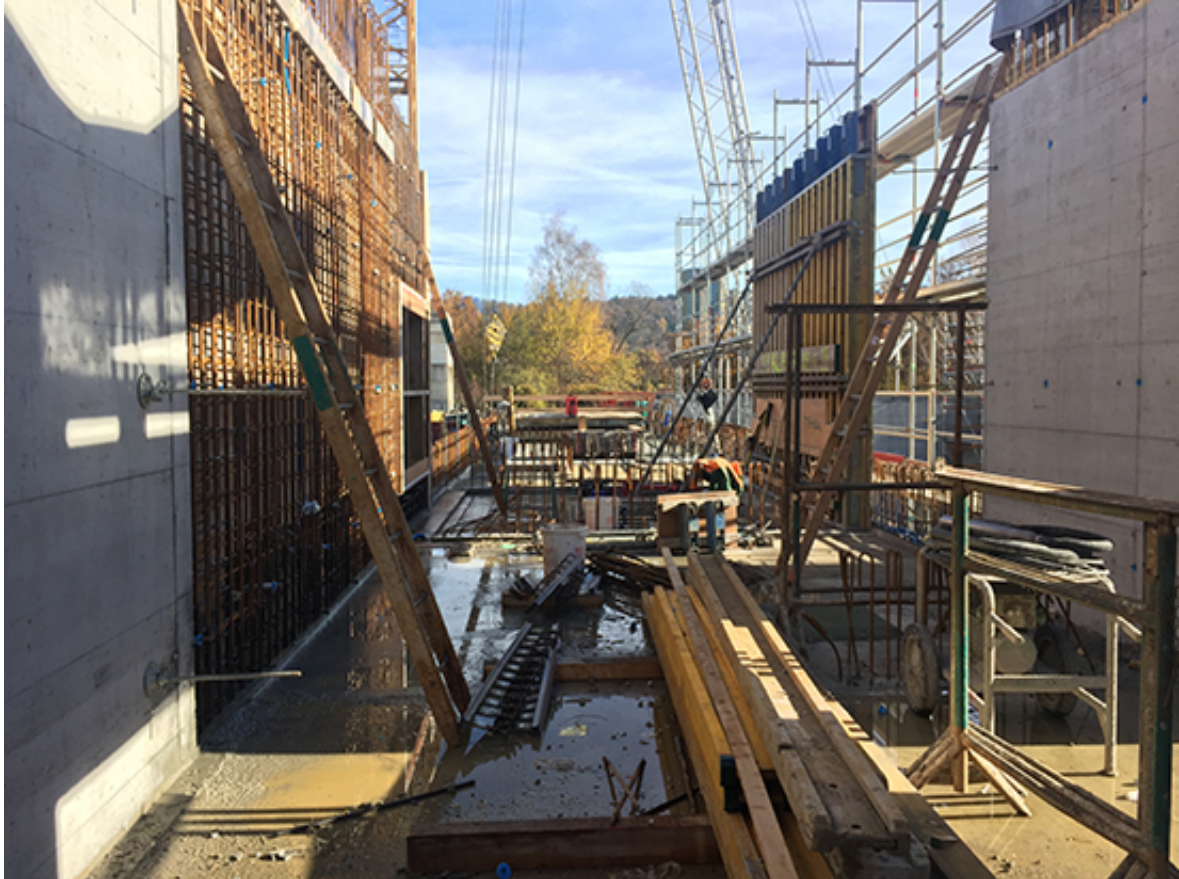
Rohbau Mittelfoyer Musikhochschule Luzern
