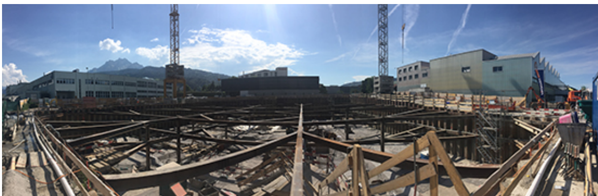
Baugrube Musikhochschule Luzern
