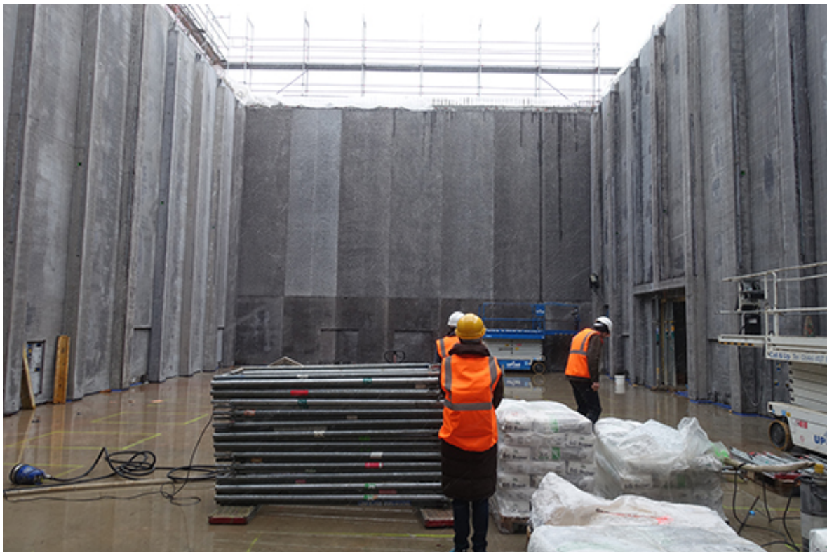
Impression der Baustelle der Musikhochschule Luzern, Januar 2018
