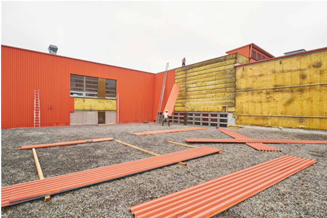
Fassadenbleche für die neue Hallenaufstockung stammen von einem Druckereigebäude in Winterthur / Foto: baubüro in situ
