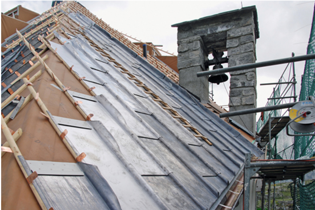
Dachkonstruktion mit Stamisol Extreme, Gotthard Hospiz, Miller Maranta Architekten Foto: Thomas Zueger, Scherrer Metec
