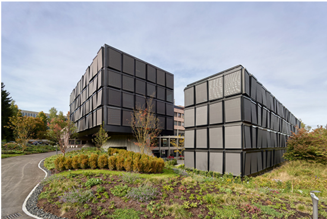
Soltis Horizon 86, Helvetia Versicherungen St. Gallen, Erweiterungen 2002 und 2017, Herzog & de Meuron
