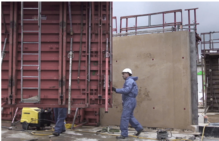
Bauen mit Flüssiglehm analog der Verarbeitung von Beton
