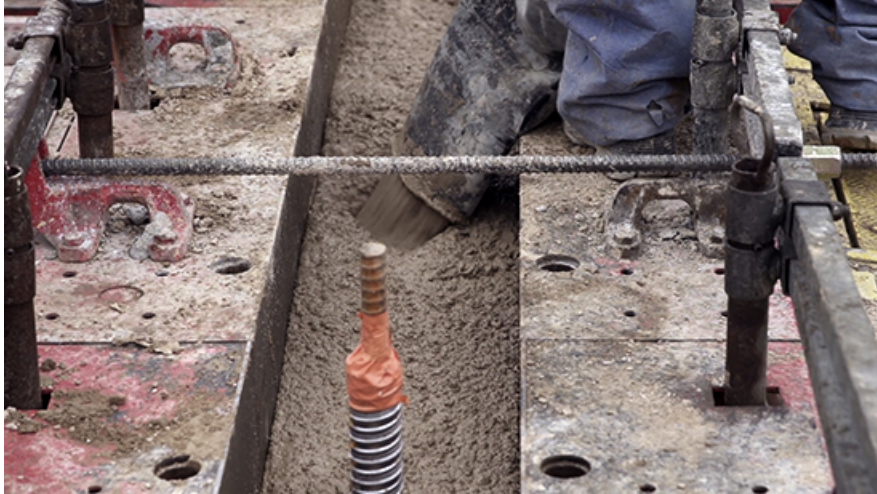
Einbringung von Flüssiglehm in eine herkömmliche Schalung für Beton
