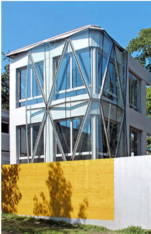
Mock-Up Fassade und Glasraute, Hauptsitz Zurich-Versicherung, Josef Meyer Stahl und Metall AG
