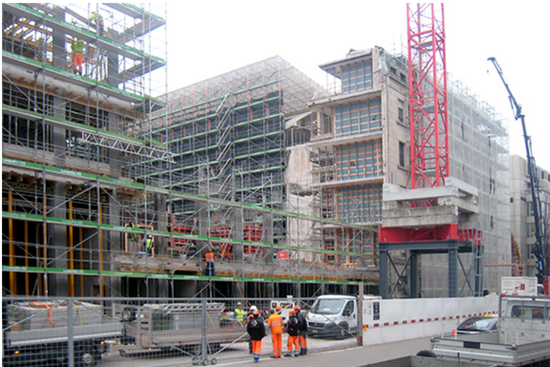
Baustelle Mythenquai Hauptsitz Zurich-Versicherung
