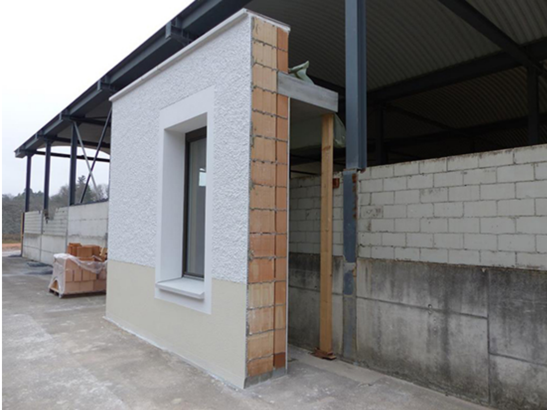
Verputztes Mock-Up des KISmur Fassadensystems
