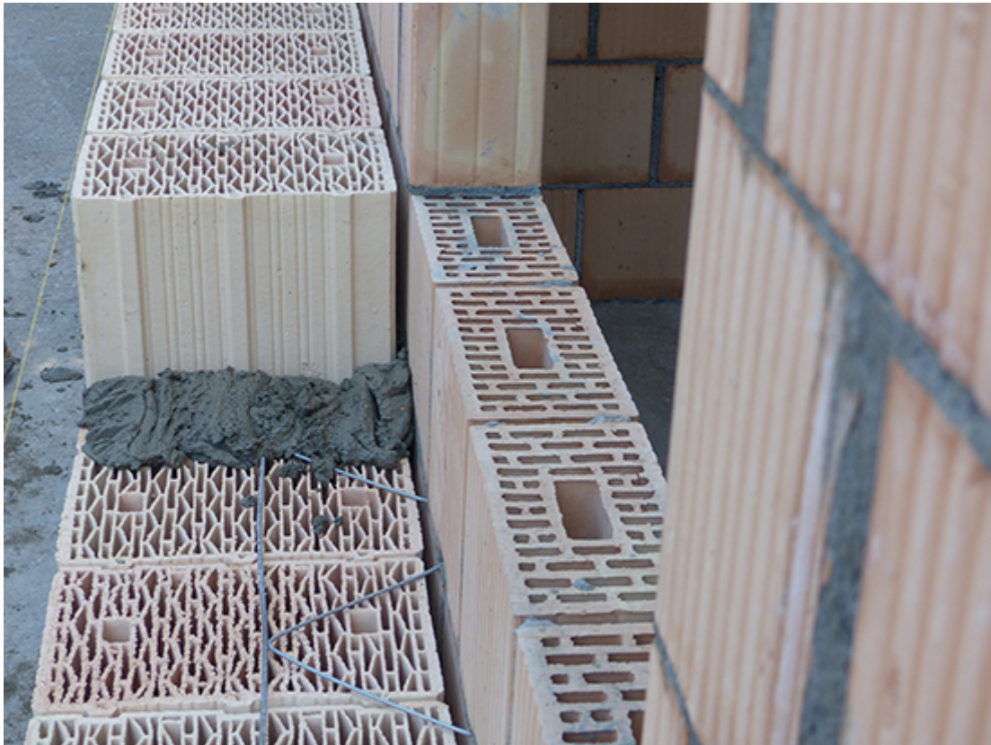
Tragende Innenschicht mit SwissModul, Dämmende Aussenschicht mit Grossblock Imbrex
