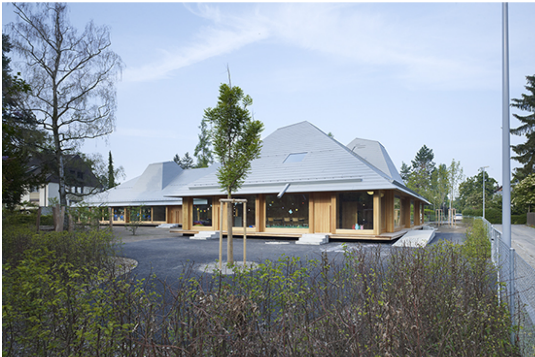
Kindergarten Paradiesstrasse, Riehen, Miller & Maranta 2018; Foto: Ruedi Walti
