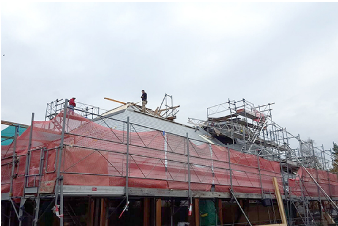
Dachdeckerarbeit, Kindergarten Paradiesstrasse, Riehen, Miller & Maranta 2018
