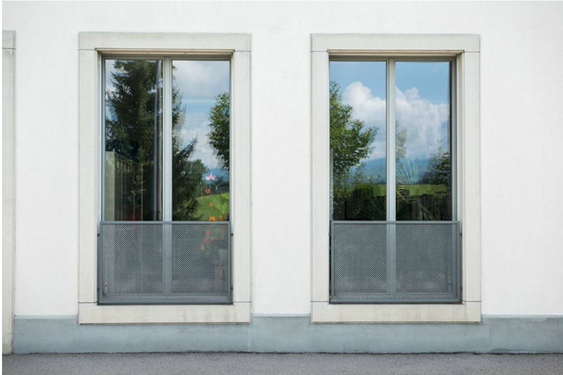
MMB Beispiel Kunststeineinfassungen, Bahnhofgebäude Rothenburg Station, Bild: MMB
