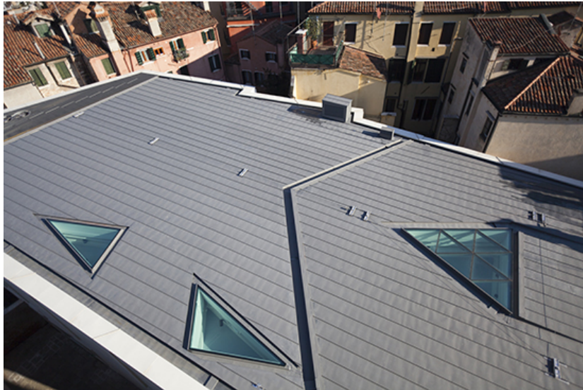
Tadao Ando Architekt, Dach in Venedig mit VMZINC®-QUARTZ
