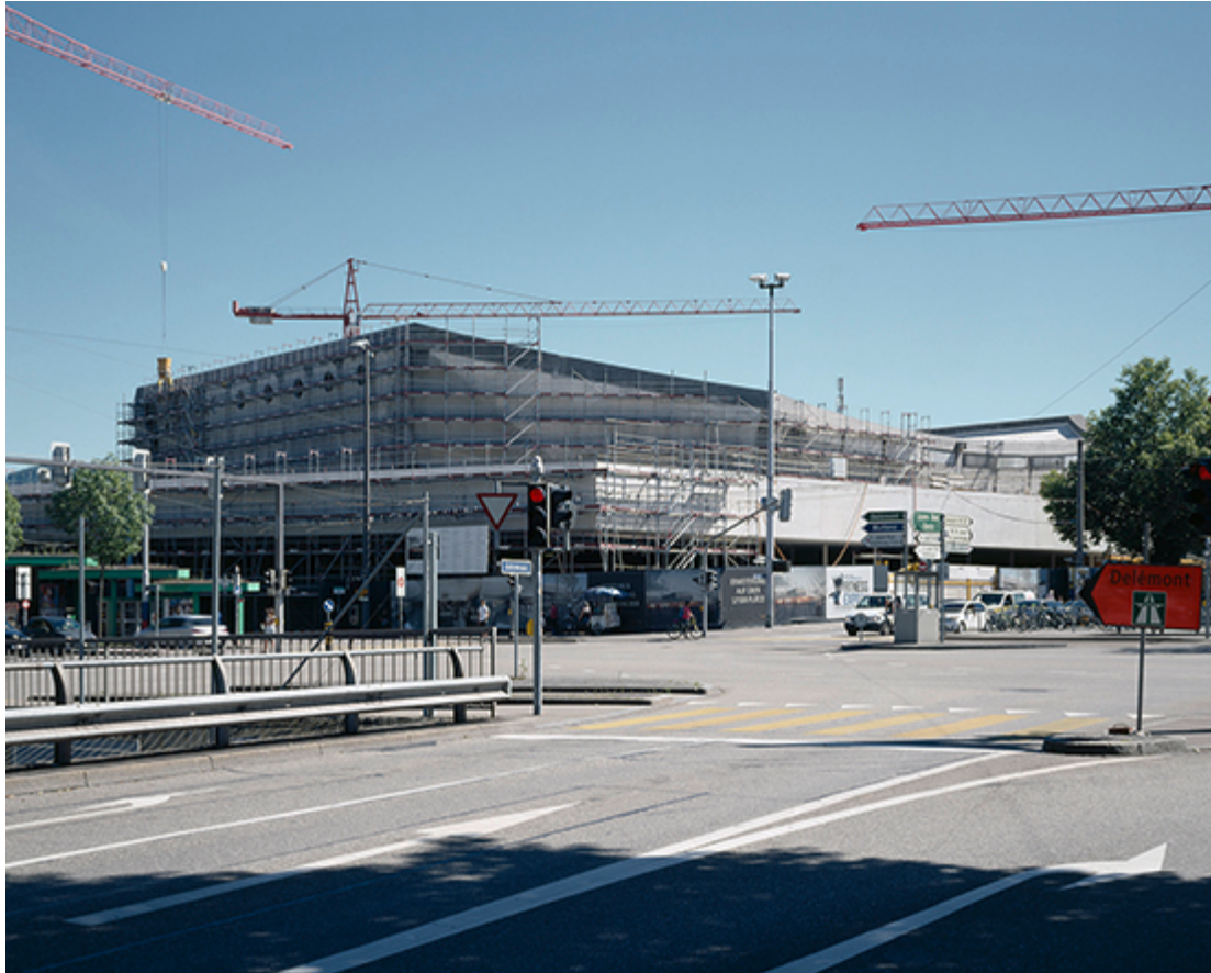
Gesamtkomplex im Bau, Berrel Berrel Kräutler Architekten AG, 2017
