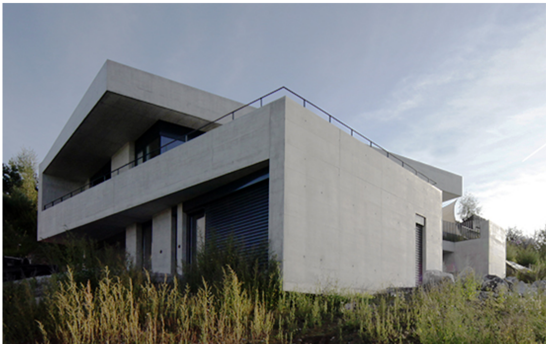
EFH St. Ursen, FR; Atelier Ducret; Sichtbetonfassade mit Multipor Innendämmung
