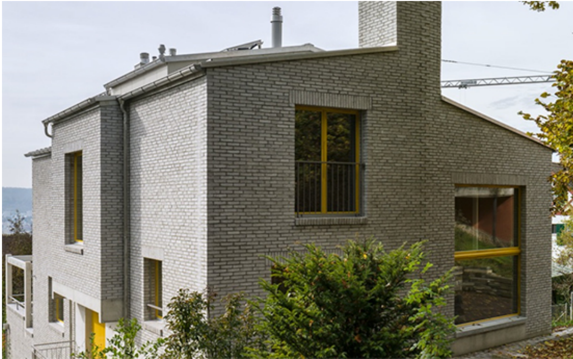
Aussenansicht Müseliweg in Zürich-Höngg, Fassade aus Beton und Klinkermauerwerk
