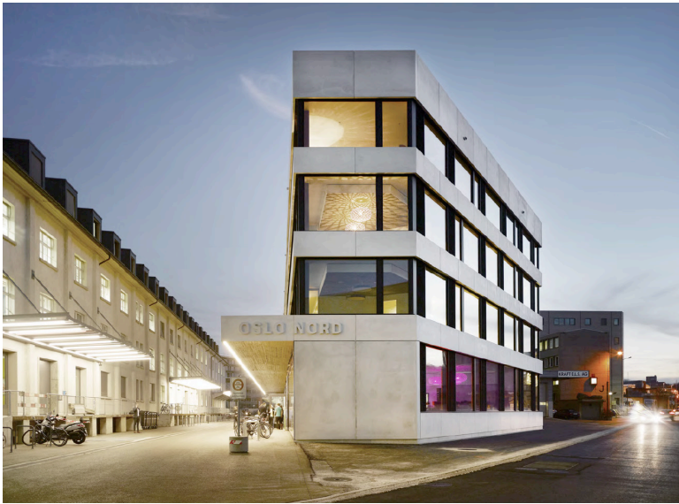
Bürohaus «Oslo Nord», Dreisitz-Areal, Münchenstein BL. ffb Architekten bauten sich ihr eigenes Bürohaus mit Gewerbe im Erd- geschoss und Wohnungen im 3. OG. (Foto: Johannes Marburg)
