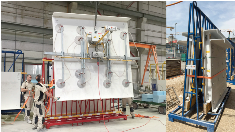
Glasfaserbeton von Stahlton: Die 20 Millimeter dünnen Elemente wurden für Münchenstein bis zu 3 Meter hoch produziert und dann abkantet. (Foto: Stahlton Bauteile AG)
