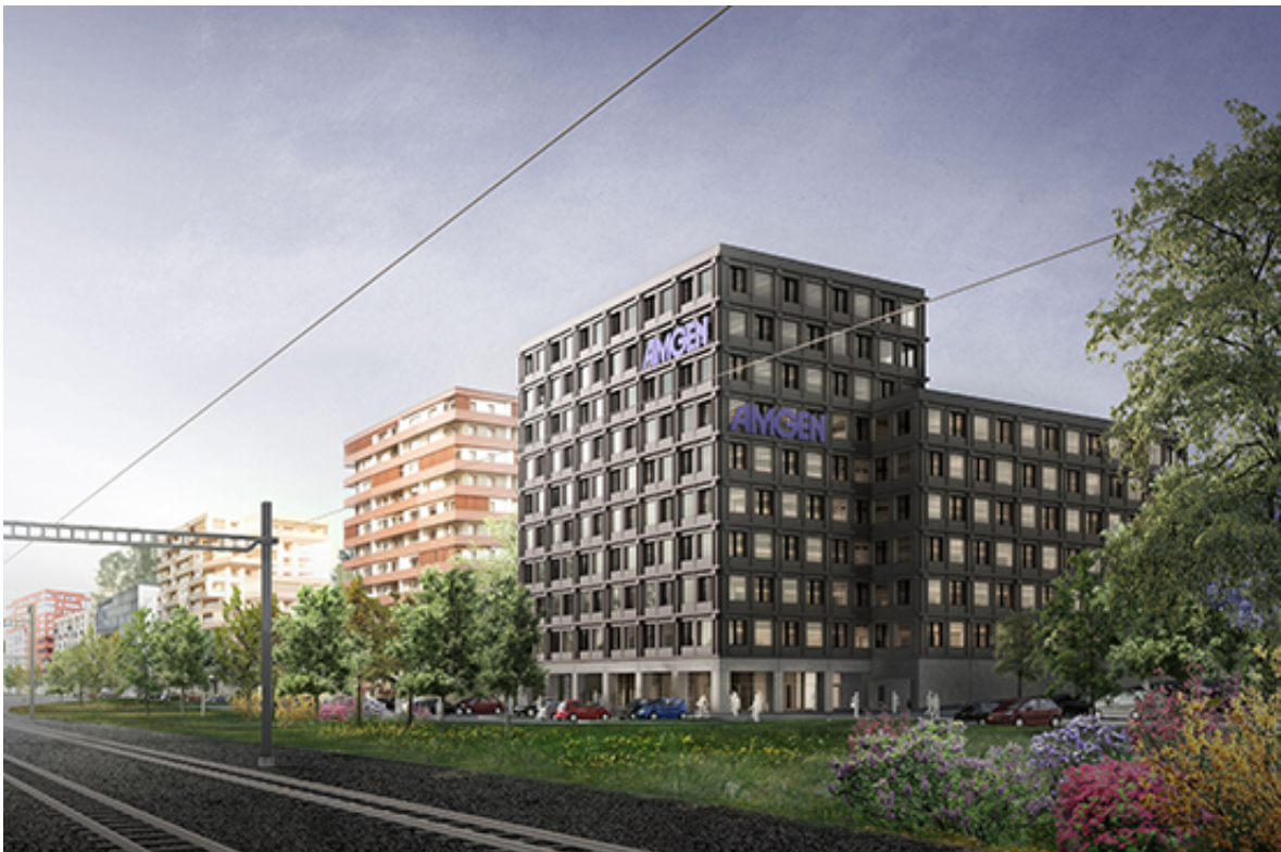
Suurstoffi-Areal, Baufeld 22, das erste Holz-Hochhaus der Schweiz
