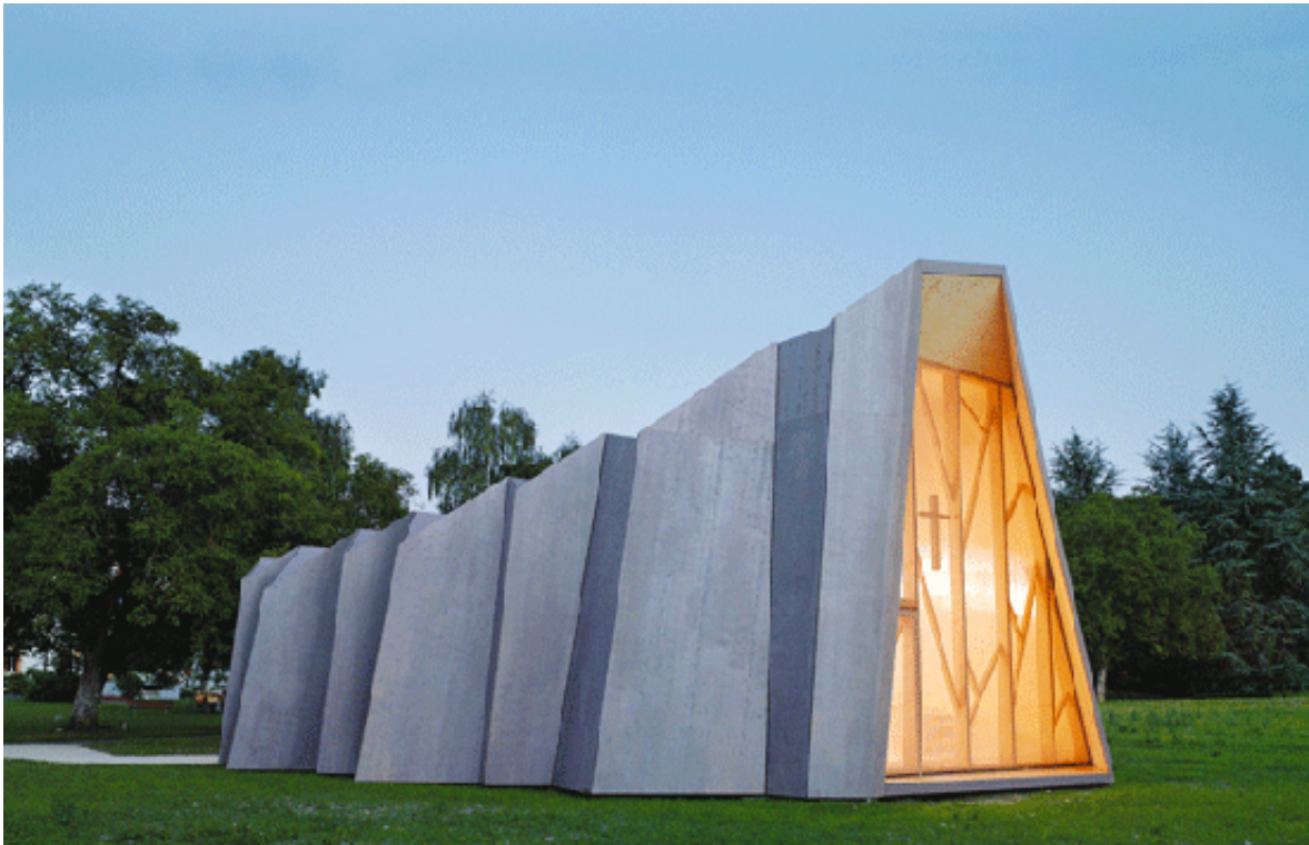
Provisorische Kapelle von St.Loup - LOCALARCHITECTURE
