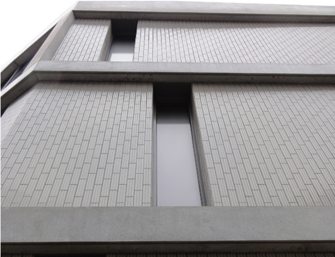
Fassadenausschnitt Wohngebäude Le Rocher, Neuenburg - LOCALARCHITECTURE
