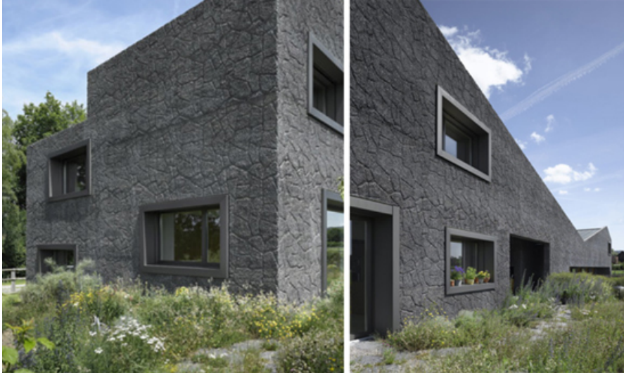
Mittels Hochdruckwasserstrahl entsteht die raue Oberflächenstruktur in der Fassade eines Wohnhauses mit Pferdestall.
