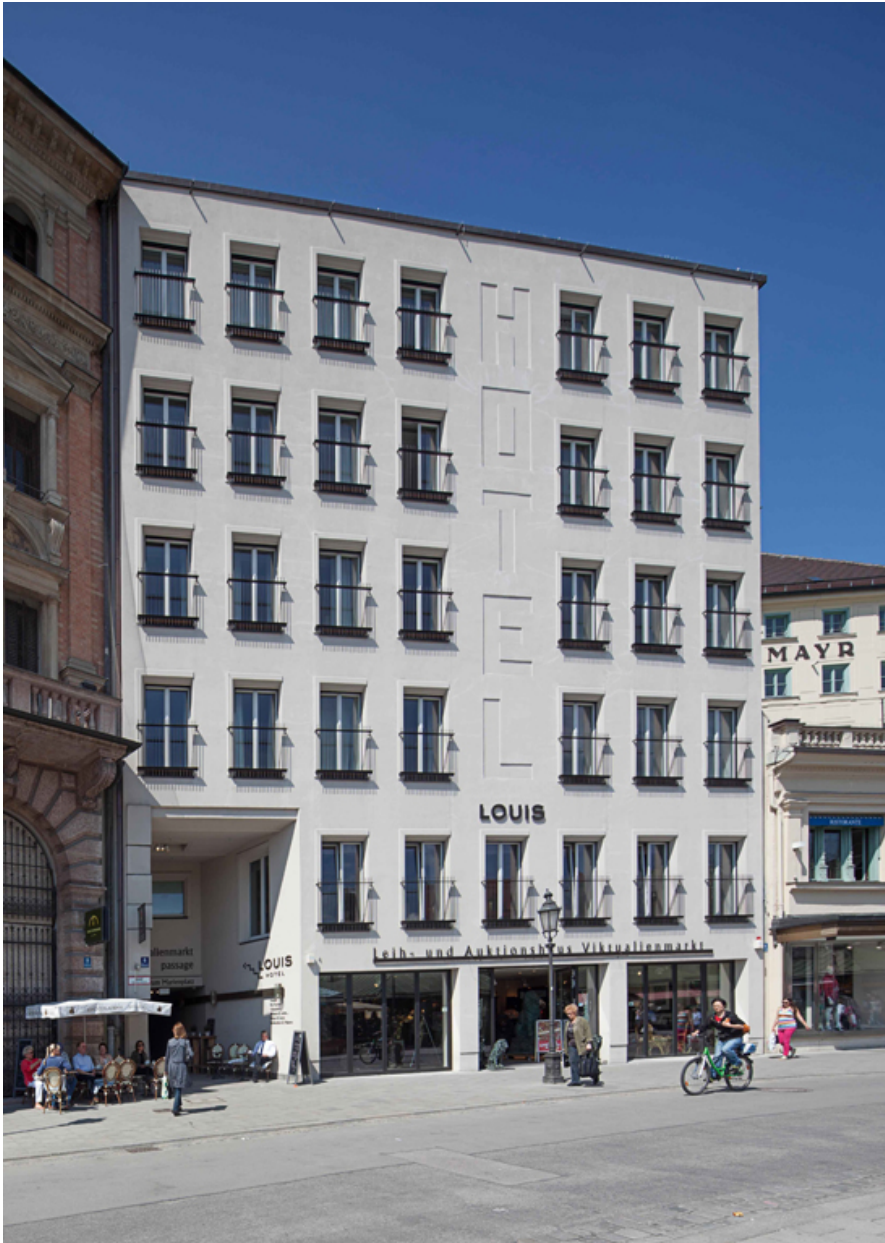
Die mächtigen Lettern als Putzrelief geben sichtbar Auskunft über die Nutzung des Gebäudes am Viktualienmarkt.
