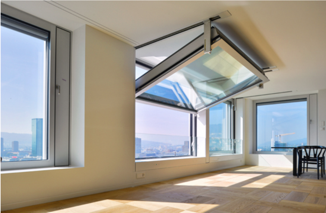
Riesige Kipp-Hub-Fenster anstelle von Balkon oder Loggia
