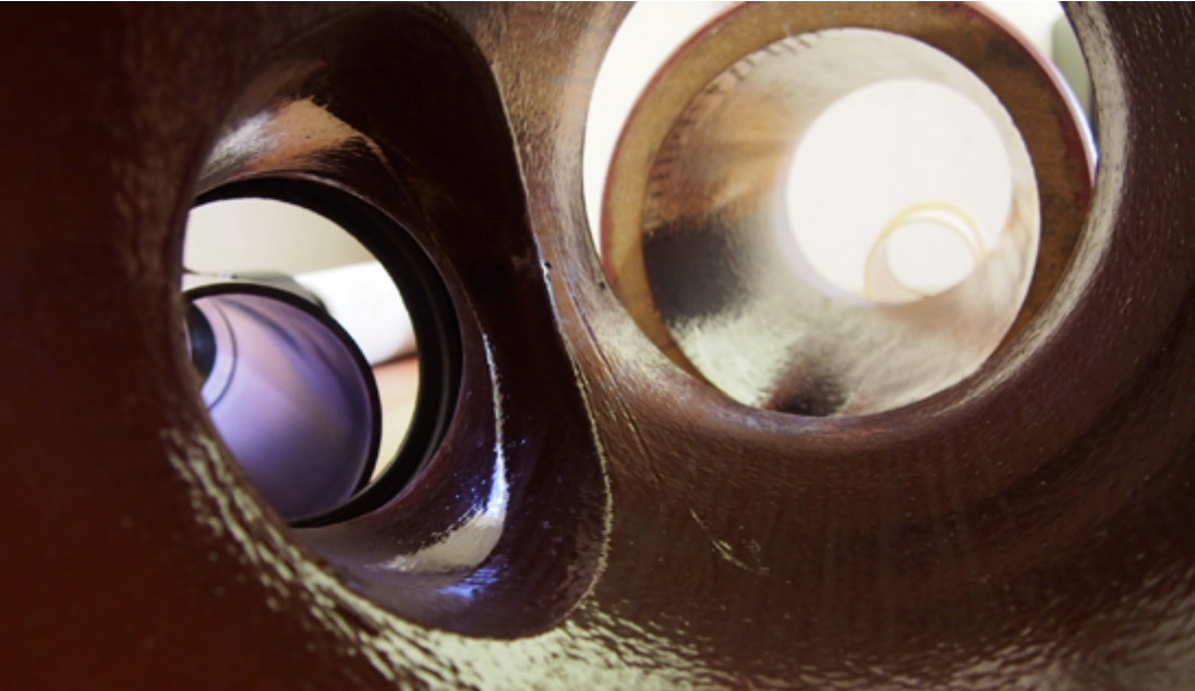
PE Rohr und Steinzeugmuffe, Bild SBCZ: Linda Pfenninger
