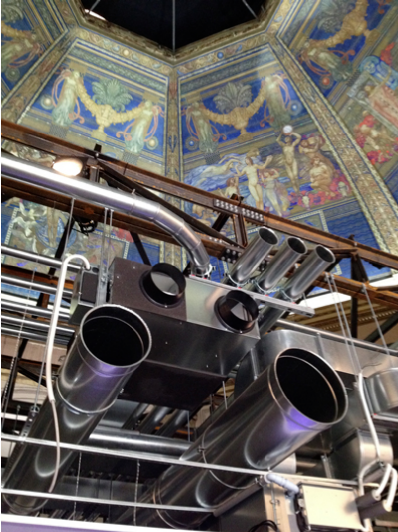
Überlagerung zweier Deckensysteme, Eingang Hauptpavillon
