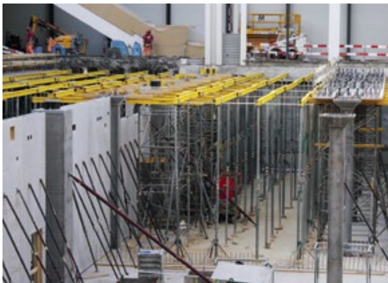
Baustelle der neuen Halle der Messe Basel, Fertigung der Elementdecken.
