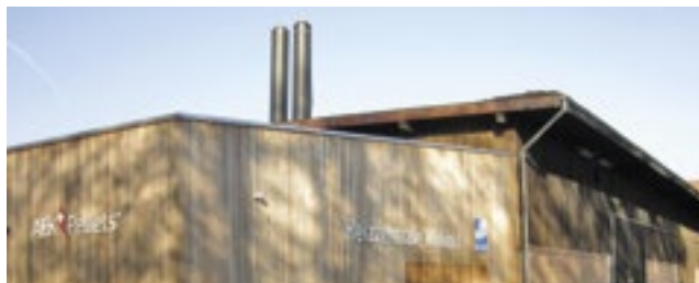
Die Heizzentrale Wylihof in Luterbach verwendet AEK-Pellets.
