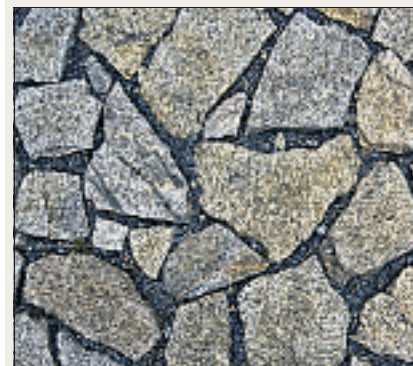
Natürlicher Bodenbelag: Granit.
