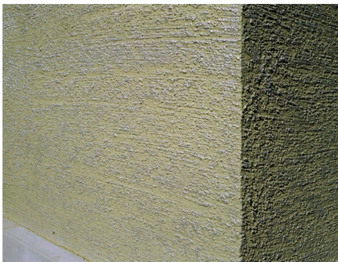
Organisch gebundener Fassadenputz Sto Stolit Effect 3 mm mit horizontaler Besenstrichstruktur, grün eingefärbt, silbrig lasiert. (Bild: Reinhard Zimmermann)
