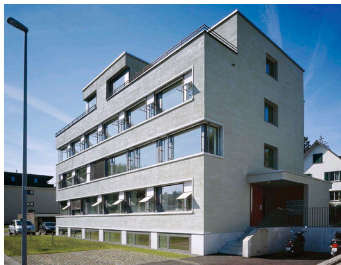
Wärme gedämmtes Bürohaus an der Gustav-Maurer-Strasse 25 in Zollikon. (Bild: Reinhard Zimmermann)
