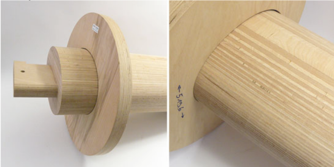
Einer der Verbindungen «-zapfen» aus verleimten Buchenlamellen
