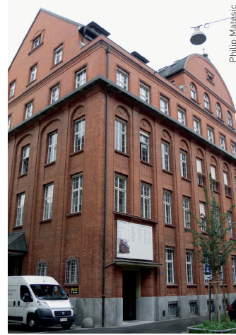
Neuer Standort SBC. Altes Gebäude. Weberhaus Baujahr 1913.
